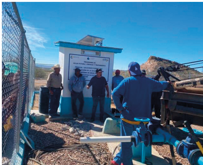
REHABILITACIÓN DE POZO SAN ANTONIO DE OJO SECO BENEFICIARIOS: MÁS DE 444 HABITANTES
