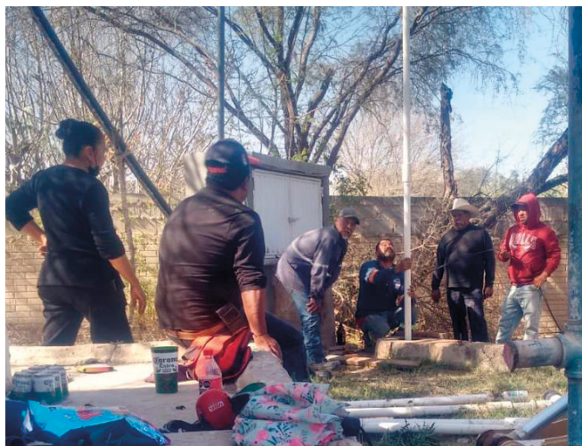
REHABILITACIÓN DE POZO VEINTE AMIGOS BENEFICIARIOS: MÁS DE 336 HABITANTES
