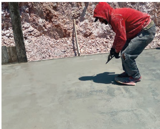
BASE PARA TANQUE DE ALMACENAMIENTO DE 10,000 LITROS EN EL PUEBLO DE SANTIAGO
