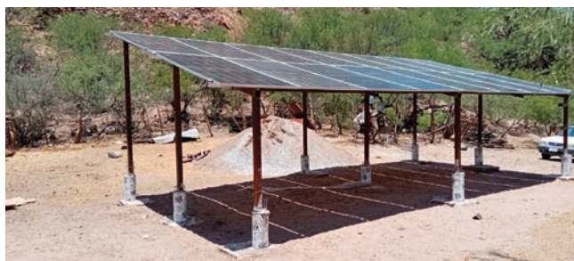
PERFORACIÓN Y EQUIPAMIENTO DE POZO EN LA CUCHILLA
