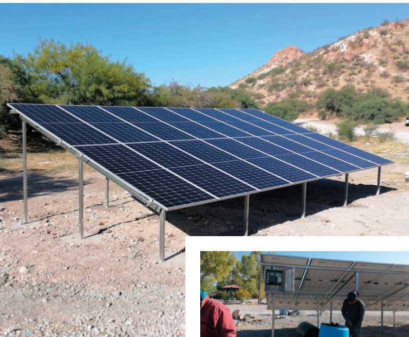
EQUIPAMIENTO DE POZO EN EL PUEBLO DE SANTIAGO DE PANELES SOLARES
