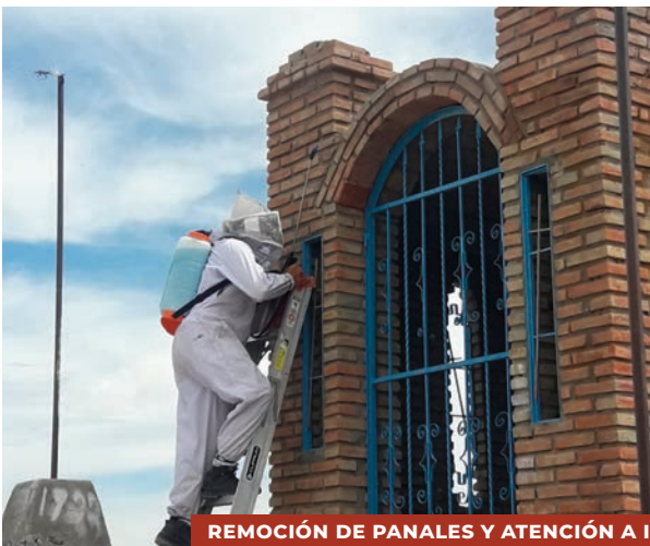
REMOCIÓN DE PANALES Y ATENCIÓN A INCENDIOS
