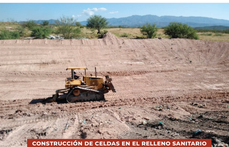
CONSTRUCCIÓN DE CELDAS EN EL RELLENO SANITARIO
