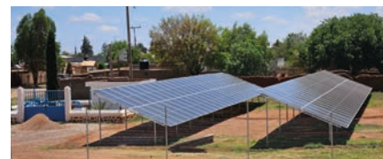
EQUIPAMIENTO DE POZO EN CUAUHTÉMOC DE PANELES SOLARES
