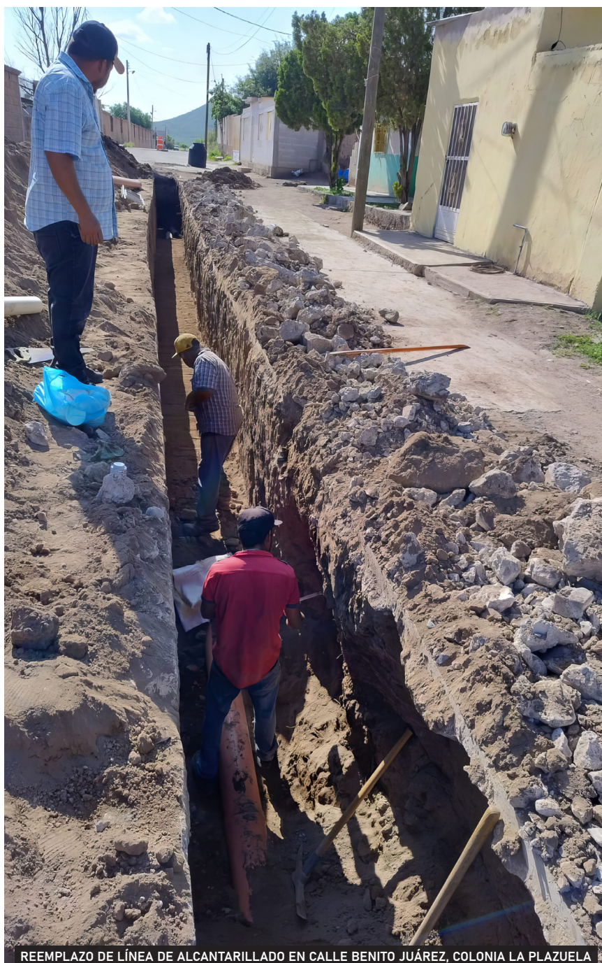
REEMPLAZO DE LÍNEA DE ALCANTARILLADO EN CALLE BENITO JUÁREZ, COLONIA LA PLAZUELA
